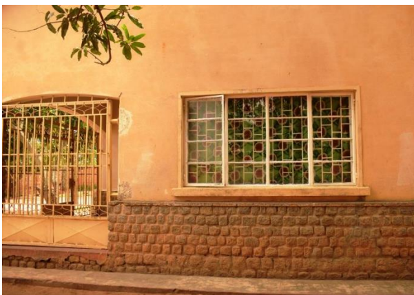
herstelde ramen en gordijnen in het meisjeshuis/ vitres réparées et rideaux à Kananga II
