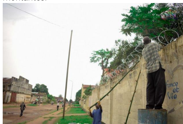
mettre le fil barbelé/ prikkeldraad wordt geplaatst
